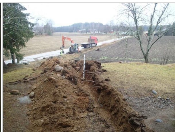
Vasen: Kaapeliotjaa kaivetaan koulun länsinurkalta kohti pellon ja tien kulmausta. Taustalla Valkeaviidantie. Oikea: Kaapelikaivantoa Letkun koulumäellä. Ohuen turpeen alla on silkkaa moreenia. Luoteeseen.
