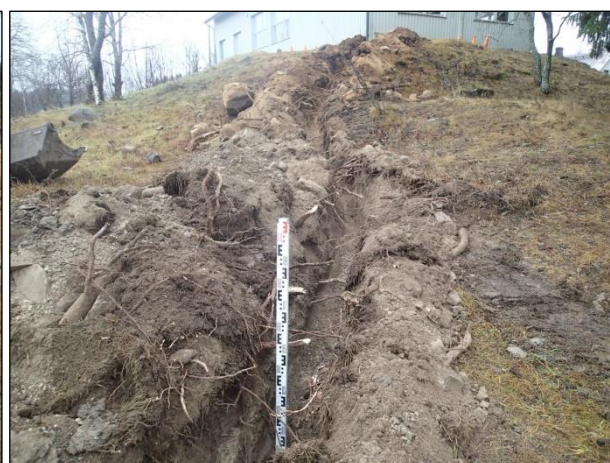
Vasen: Kaapelikaivantoa Letkun koulumäellä. Ohuen turpeen alla on hiekkamoreeni. Oikea: Kaapelikaivantoa Letkun koulumäellä. Alarinteessä ja rinteen juurella savea, ylempänä mäessä hiekkamoreenia. Itään.
