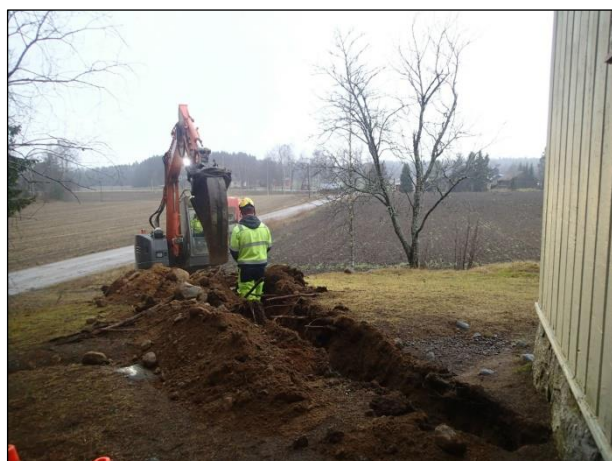
Vasen: Kaapeliotjaa kaivetaan koulun länsinurkalta kohti pellon ja tien kulmausta. Taustalla Valkeaviidantie. Oikea: Kaapelikaivantoa Letkun koulumäellä. Ohuen turpeen alla on silkkaa moreenia. Luoteeseen.
